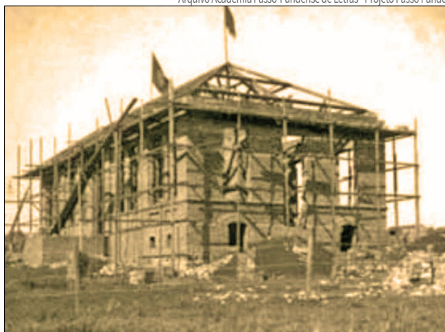
Em construção: o prédio do Hospital de Caridade ainda não estava pronto em 1918
