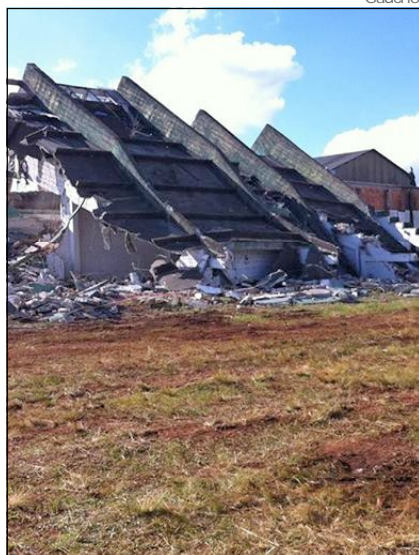
ABR: Agora é definitivo. Pavilhão do estádio Wolmar Salton é demolido
