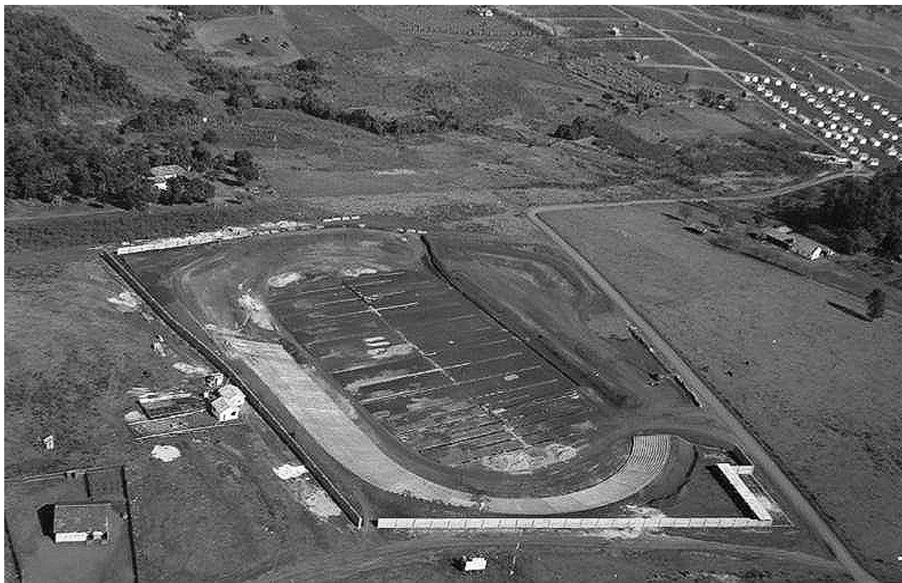
O nascimento do gigante: arquibancadas e drenagem sendo construídas no Vermelhão
